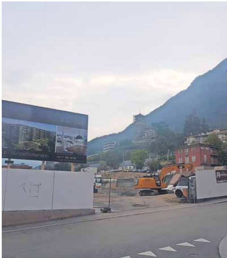
Sopra, il cantiere a Paradiso. Sotto, due rendering del progetto. (foto GdP)
